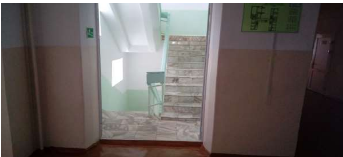
№ 16 Лестница внутри здания На стене план эвакуации (на всех этажах)
